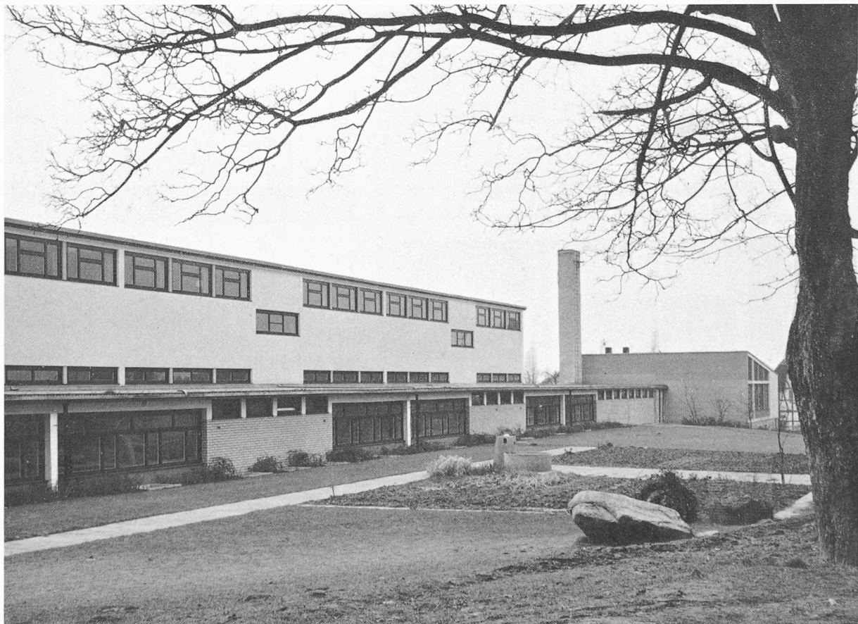
Nordwestfassade der Oberschule, hinten Singsaal
