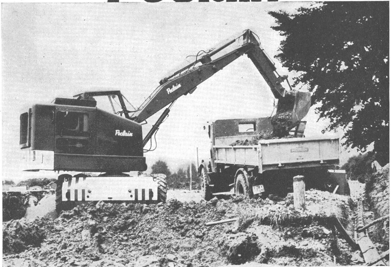
Unser Bild: Verladearbeiten im Strassenkoffer
