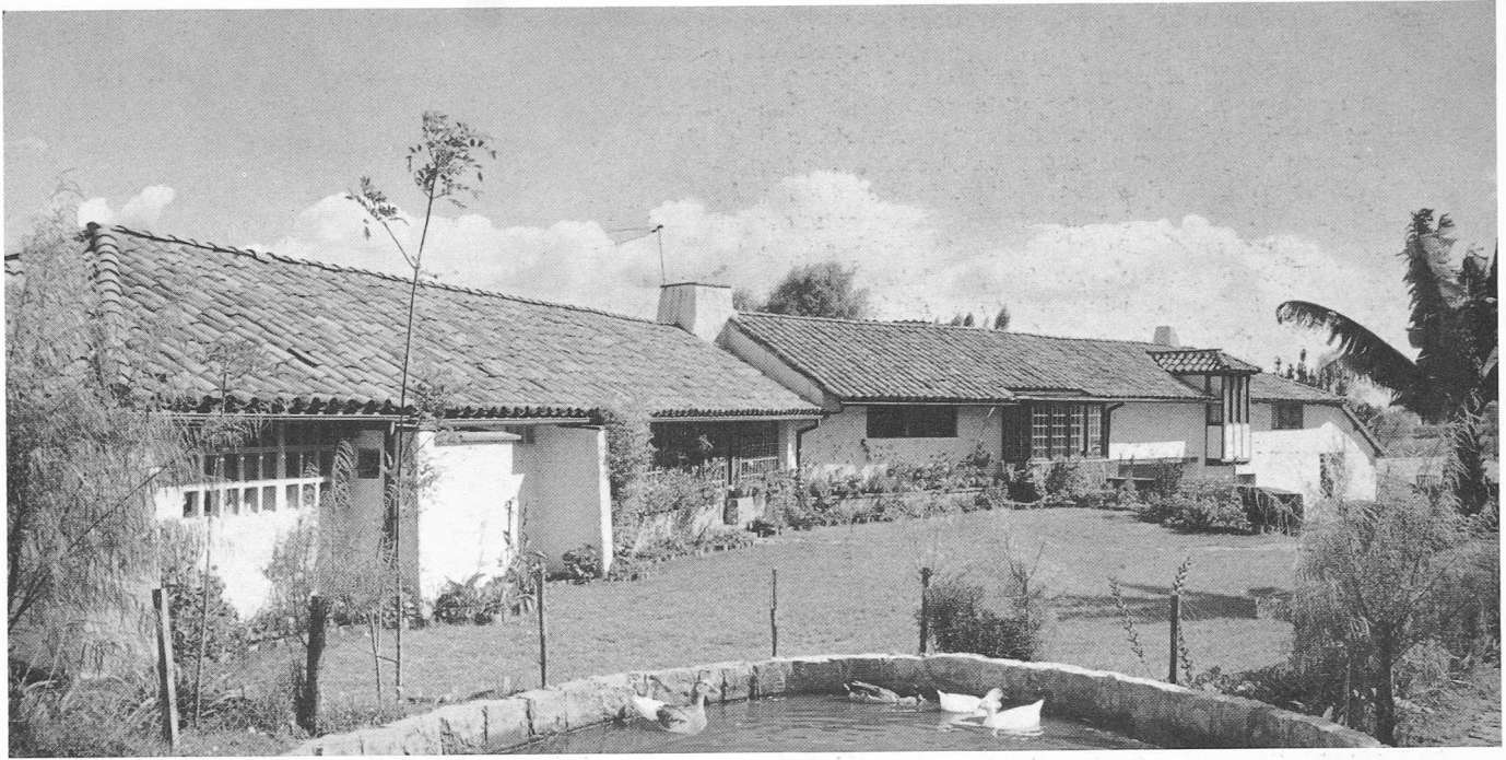
Landhaus Dr. Cota. Zwei Ansichten der Westseite. Die Photos wurden nach Fertigstellung der 3. Etappe aufgenommen. Der kleine Westflügel fehlt. Grundriss siehe Seite 838
