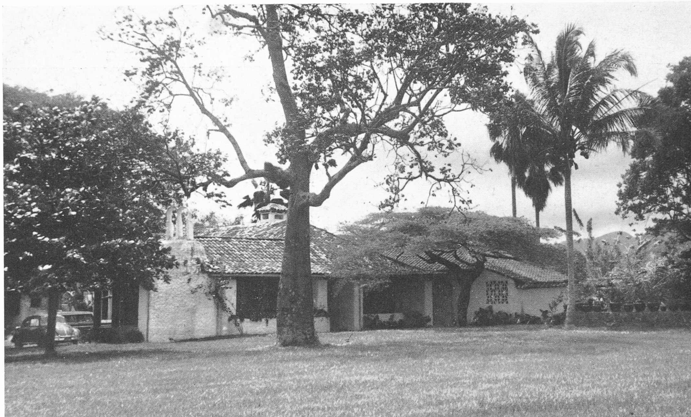
Farmerhaus «La Palma» (1949—55). Dieses Farmerhaus ist das Zentrum eines landwirtschaftlichen Grossgrundbesitzes von der Grösse des Kantons St. Gallen. Die Farm befindet sich seit sechs Generationen im gleichen Familienbesitz. Das baufällig gewordene Stammhaus wurde von Victor Schmid umgebaut und der ganze Gebäudekomplex in Etappen auf die heutige Grösse ausgebaut. Der Gebäudekomplex kann 45 Personen beherbergen und durch Anfügen weiterer Einheiten wieder vergrössert werden. Alle für den Rohbau verwendeten Materialien konnten von dem Gute selbst bezogen und mit eigenen Leuten verarbeitet werden
