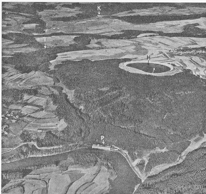
Bild 3. Reisachwerk mit Hochspeicher Rabenleite H, Pumpspeicher-Krafthaus Reisach-Rabenleite P, Krafthaus Tanzmühle T und Kainzmühlensperre K.
