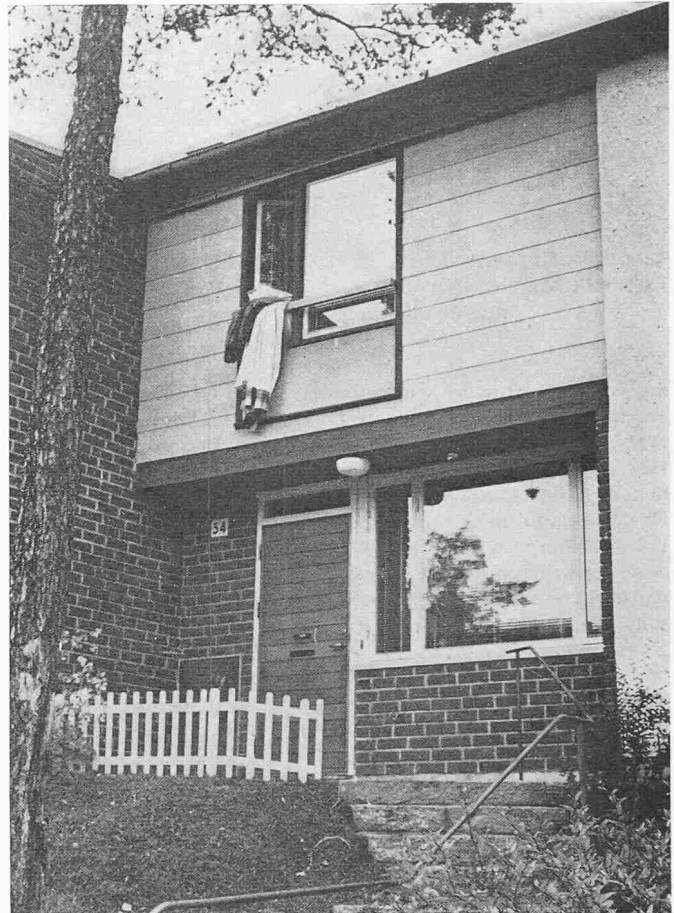
Bild 12. Gutes Beispiel für Elementbauweise: «Siporex»- und Fensterelemente im Reihenhausbau
