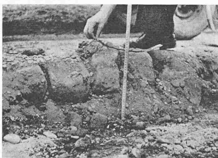
Bild 1b. Einzelheit zu Bild 1a, die Hebung betrug 31 cm
