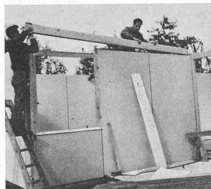
Die Pfette wird von oben eingefügt
