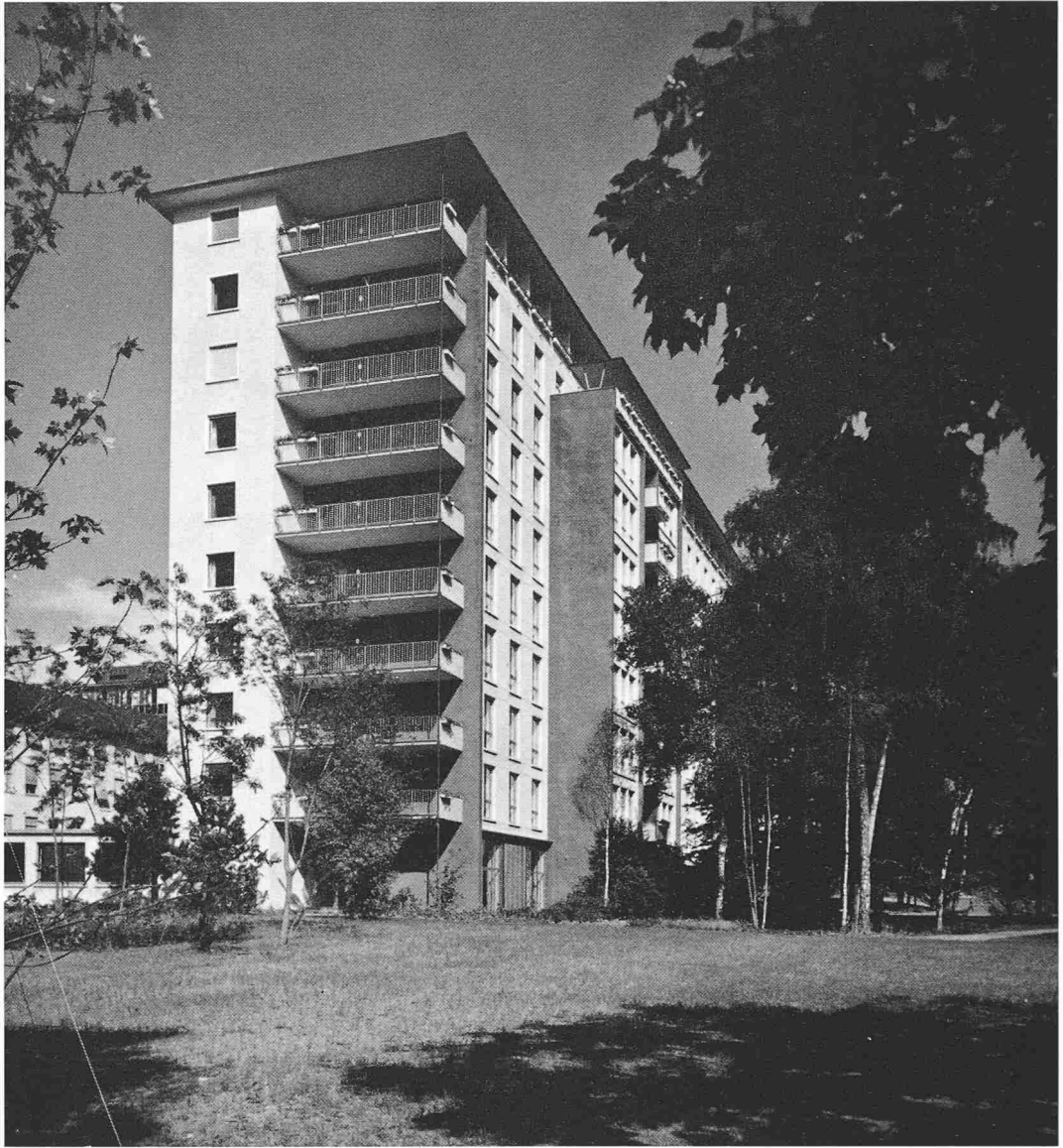
Ansicht des Bettenhauses von Westen. Rechts sind die vorgezogenen Mittelpartien der westlichen Pflegeeinheit mit den 6er-Zimmern, links hinten der Behandlungstrakt sichtbar.
