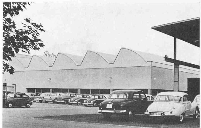
Bild 27. Südwestansicht der Shedhalle
