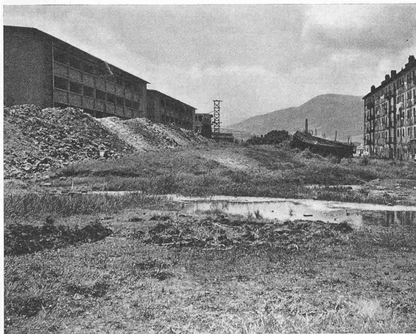
Fig. 2. Vue du glissement
