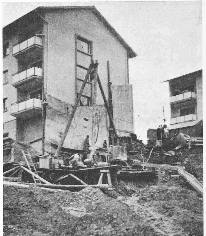
Bild 7. Gebäudeunterfangung an einem Steilhang
