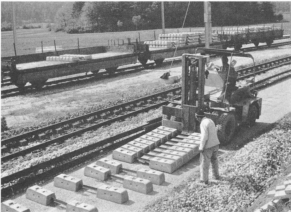
Bild 1. Abladen und Verteilen der Betonschwellen mit Gabelhubstapler
