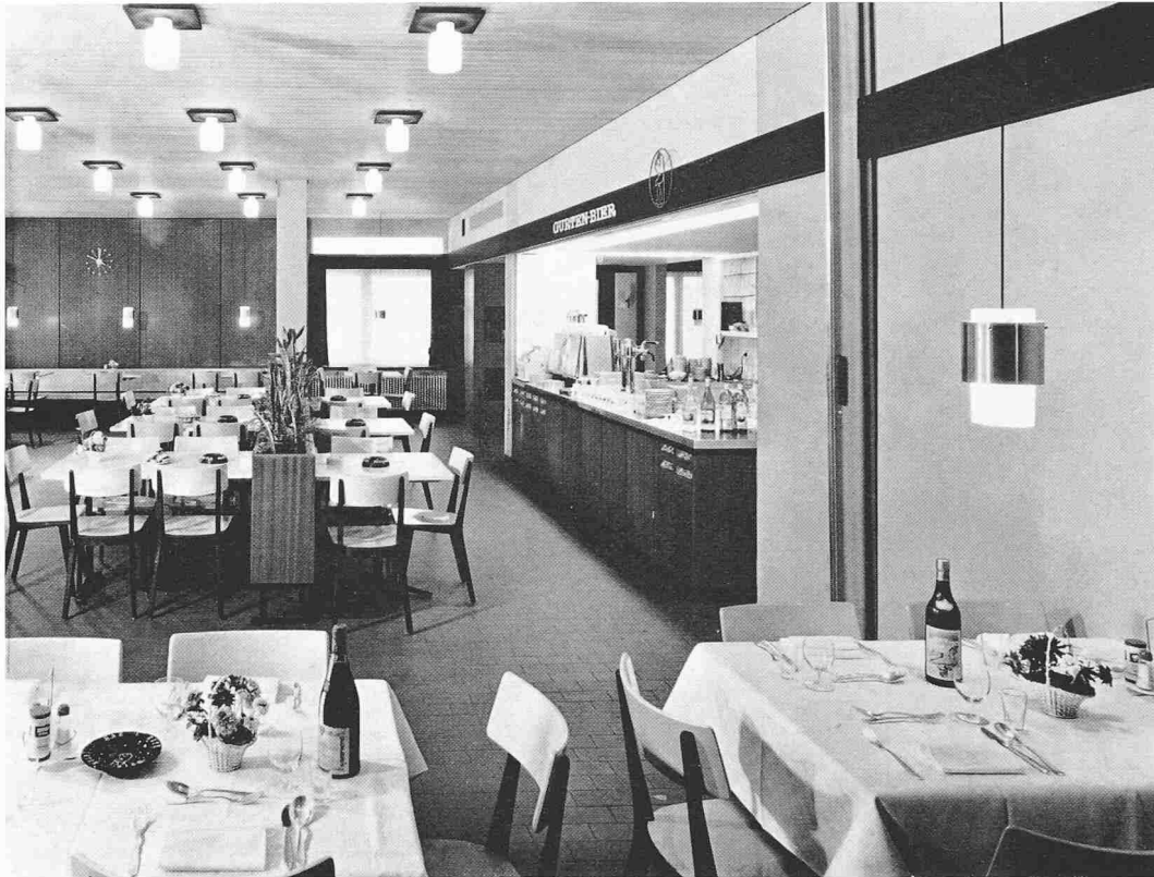
Gaststube des Restaurants beim Hochhaus Standstrasse
