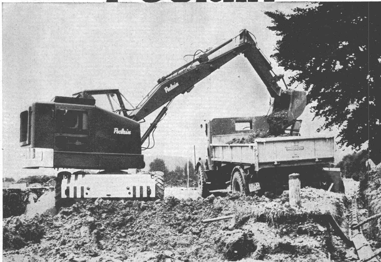
Unser Bild: Verladearbeiten im Strassenkoffer
