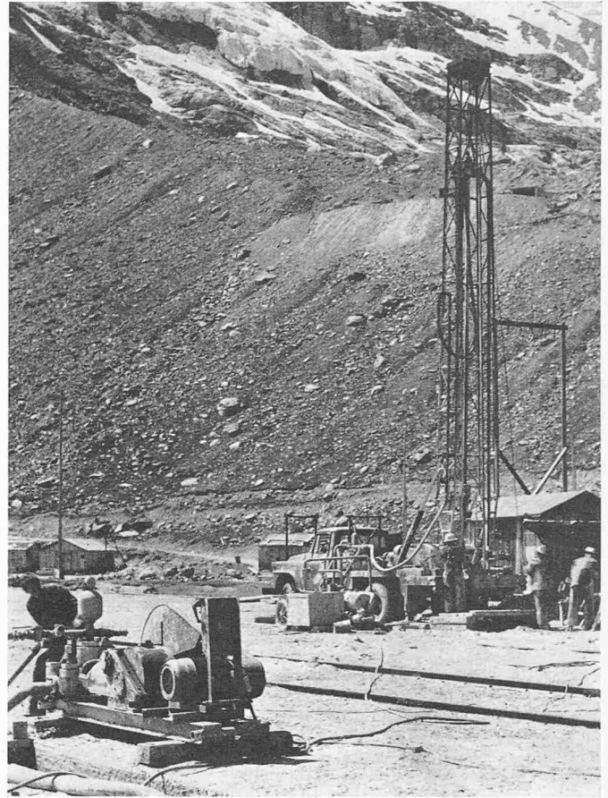
Bild 22. Bohrgerät Rotary Keystone-Frank mit Pumpe
