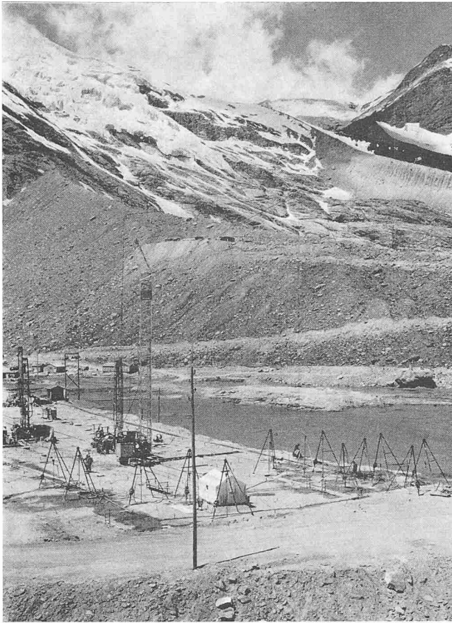
Bild 25. Blick über das Injektionsfeld
