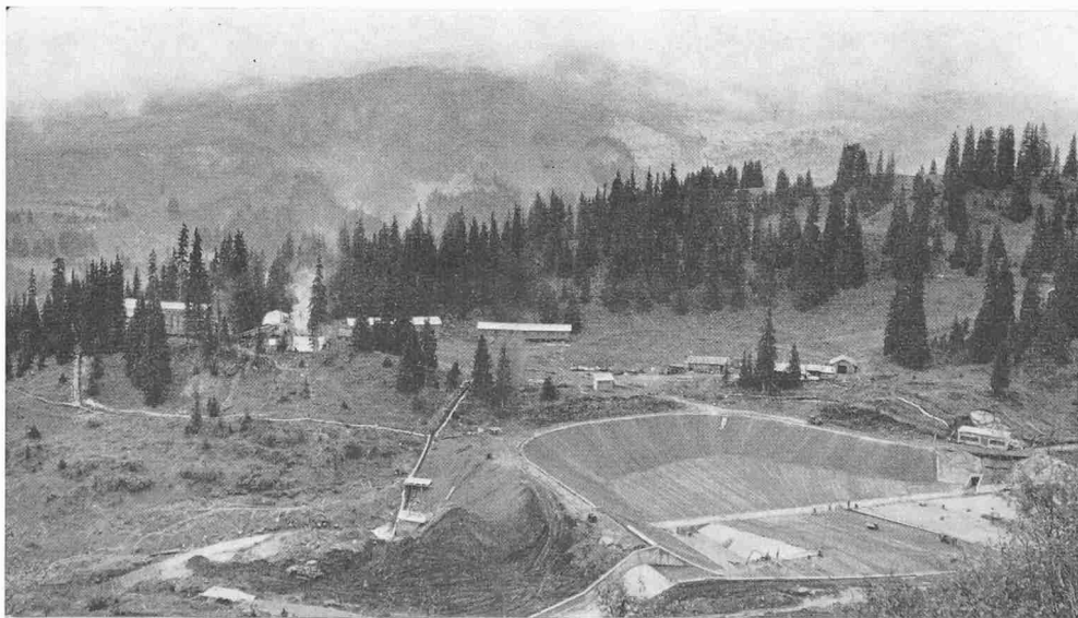
Bild 7. Ausgleichsbecken Teufлаui. Rechts Auslauf des Zuleitungsstollens, darüber Schieberhaus und Trafostation. Im Vordergrund Stolleneinlauf und Kronenüberfall. Links, am Fusse des Abschlussdammes, das Schieberhaus für den Grundablass
