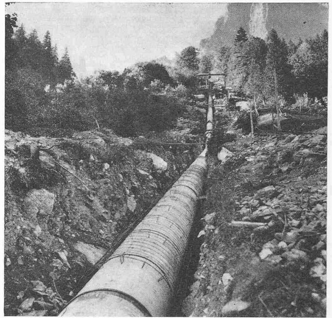
Bild 12. Druckleitung vom Wasserschloss Birchlaui nach der Zentrale Führen, Bauzustand 30. Sept. 1959
