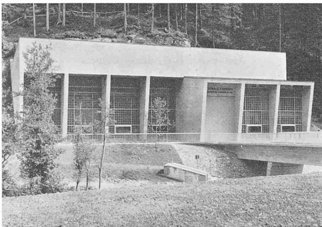
Bild 14. Ansicht der Zentrale Fuhren
