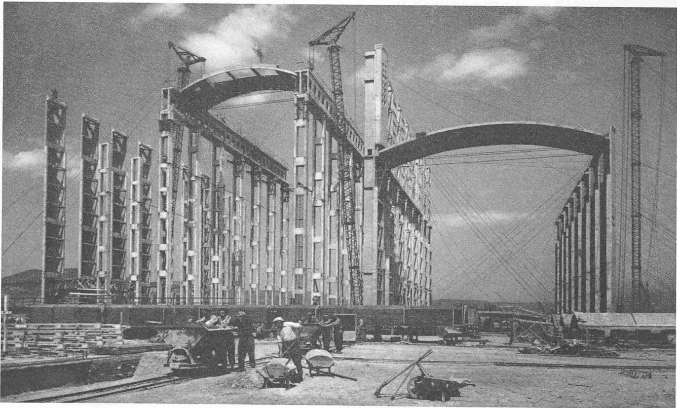
Bild 3. Rechts die 25 m weite Maschinenhalle, links davon das 19 m weite und 33 m hohe Kesselhaus, wo die horizontalen Träger für die Dachelemente sowie diese selbst deutlich ersichtlich sind
