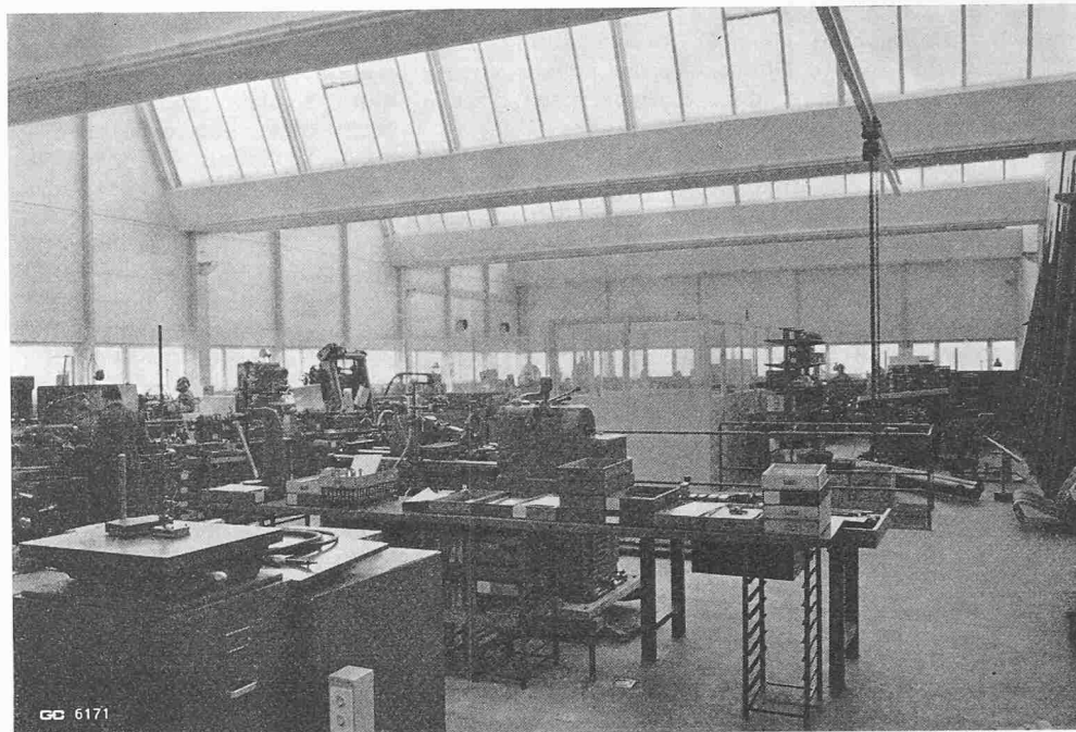
Bild 9. Werkhalle (Shedkonstruktion System GC)
