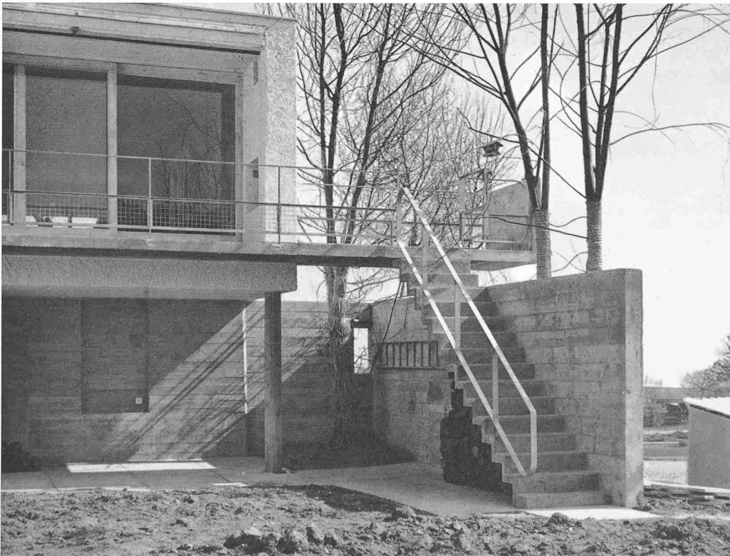
Gartenseitige Treppe zum Wohnzimmer-Balkon
