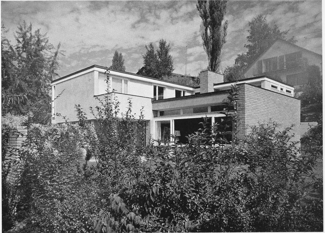
Wohnhaus an der Wirzenweid in Zürich 7, aus Südwesten
