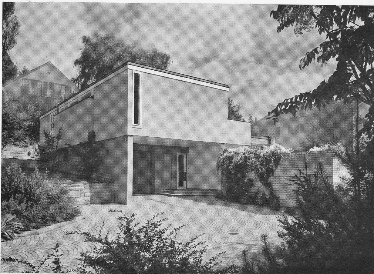
Eingangs-Ecke des Hauses an der Wirzenweid, aus Nordwesten
