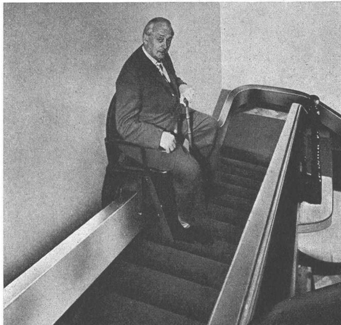
heitsvorrichtung versehen. Der geräuschlos arbeitende Antrieb (Motor, Reduktionsgetriebe, automatische Bremse, Geschwindigkeitsregulator, Friktionsrollen, Kabelspanntrommel usw.) ist unter dem Sitz mit Blech verschalt. Der Aufzug kann überall eingebaut werden, Anschluss am Lichtnetz genügt. Er ist der Aufzug für ältere und gehbehinderte Leute in Privathäusern, Sanatorien, Altersheimen, Kurhäusern und Hotels.
