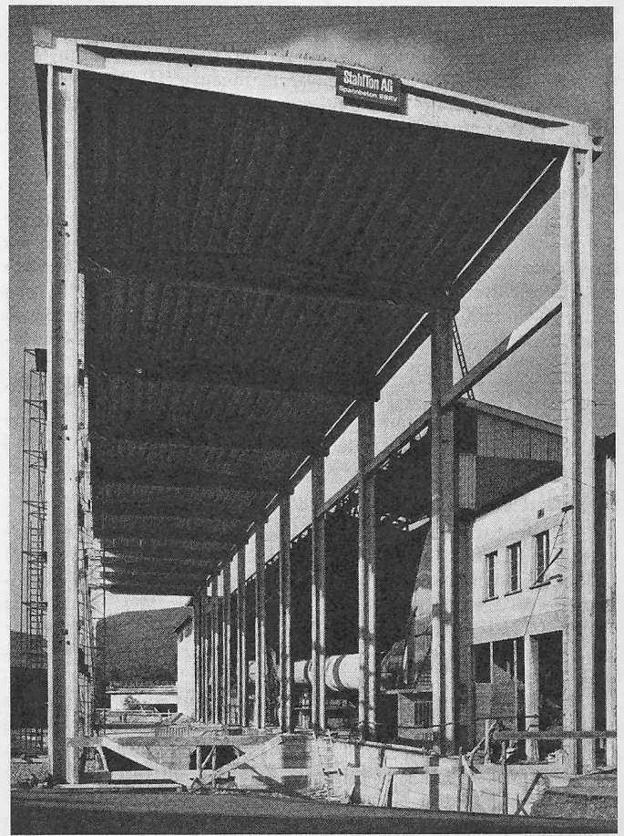
Bild 2. Fertig eingedeckte Hallenkonstruktion aus vorfabrizierten Rippenplatten. Abmessungen der Halle: Länge 124 m, Breite 16 m, Höhe 20 m
