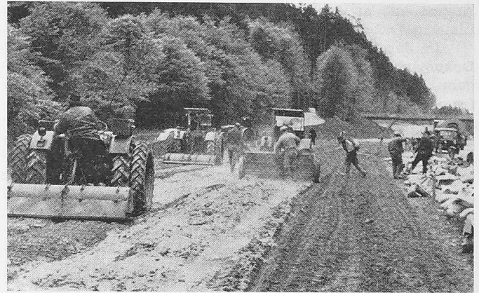
Bild 5. Nationalstrasse Nr. 1 Bern — Zürich. Einbau einer mit Zement stabilisierten Schicht beim Grauholz (nördlich von Bern). Rechts aufgelockertes Fundationsmaterial, in der Mitte Verteilen des Zementes, links Mischen
