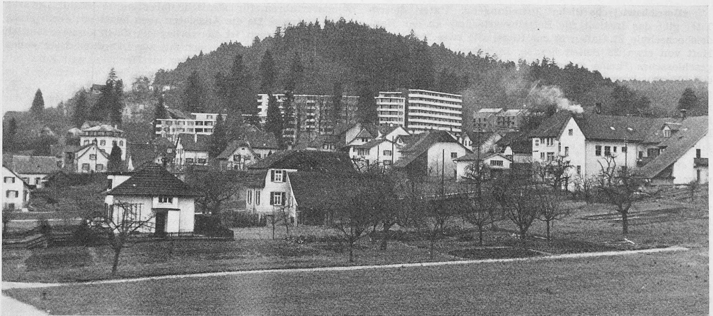
Ansicht des Tannengutes aus Nordosten
