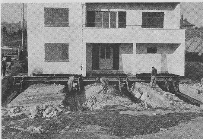
Bild 1. Haus (ohne Keller) am alten Standort, acht Rücklaufsicherungen
