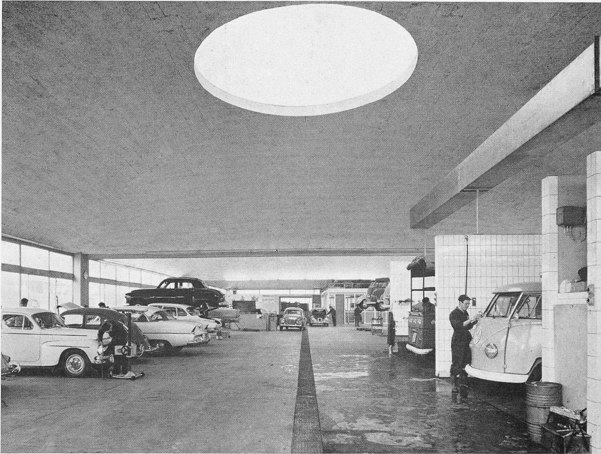
Blick in die Werkstatt, rechts die von aussen her erreichbaren Waschräume mit darüberliegender separater Ventilation
