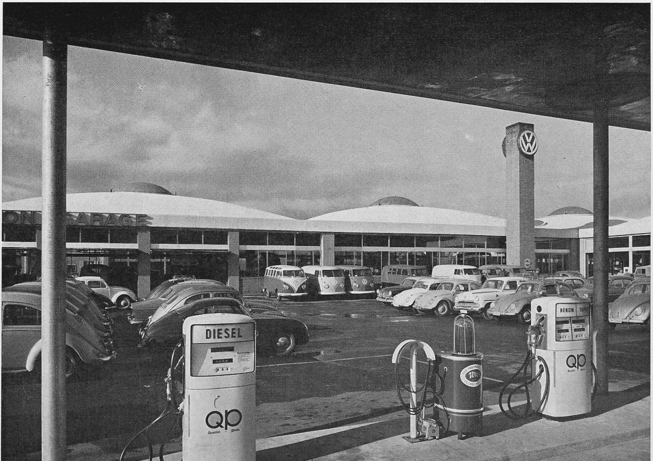
Ansicht von der Tankstelle gegen den Werkstatt-Trakt
