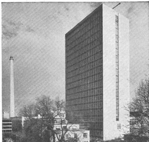
Im Hochbau für hohe Festigkeiten
