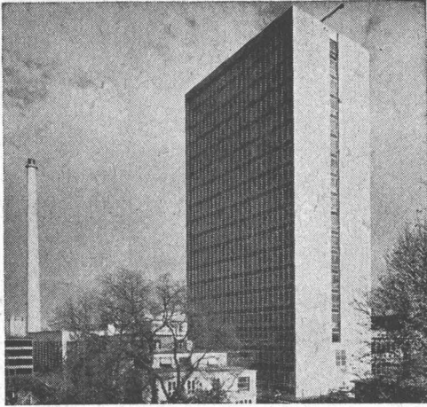
Im Hochbau für hohe Festigkeiten
