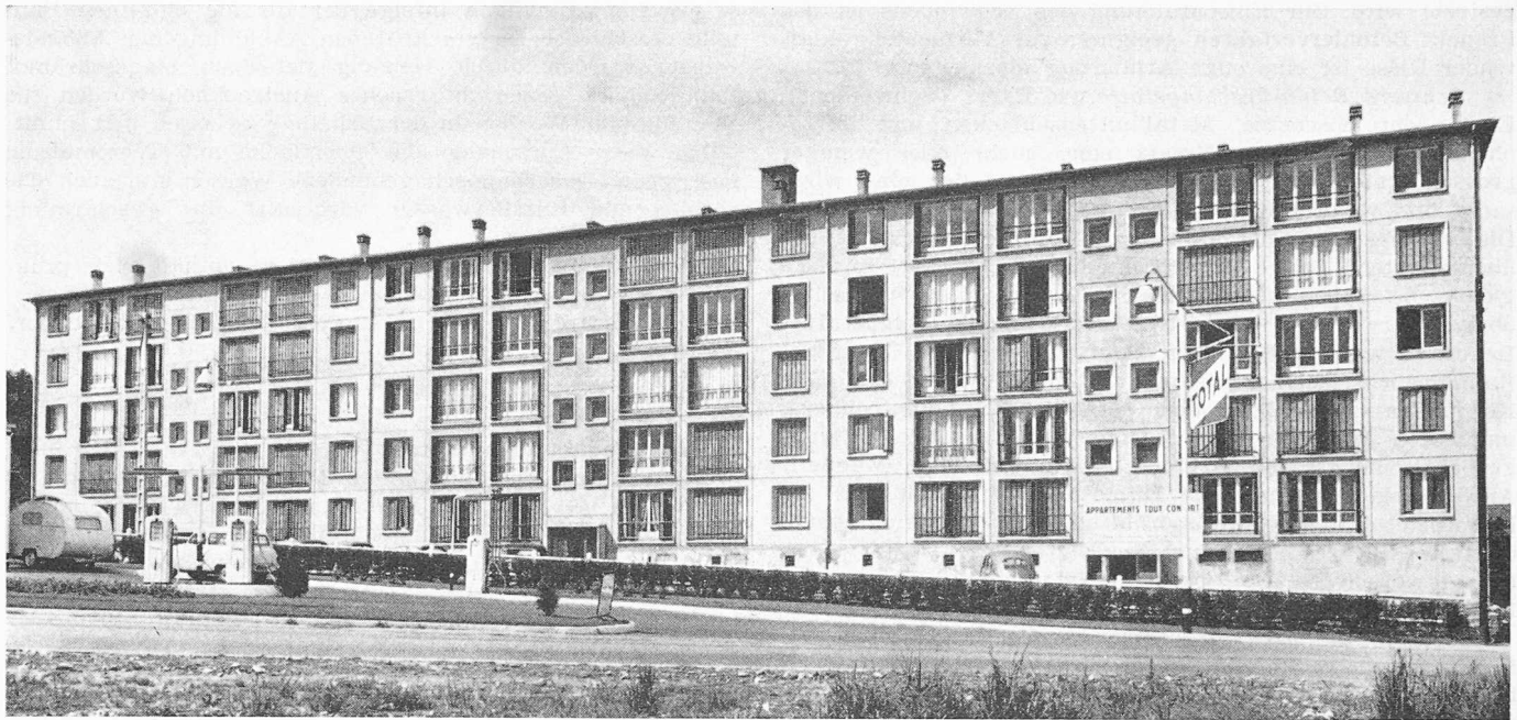
Bild 36. Wohnbaufassade mit Grosstafeln, System Coignet
