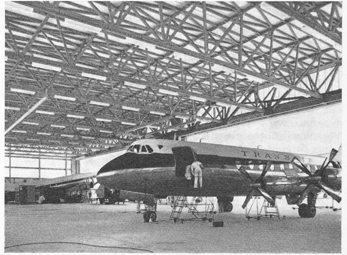
Bild 12. Die fertiggestellte Flugzeughalle mit Torträger
