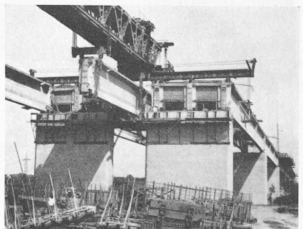
Bild 26. Heben eines langen Brückenträgers in Deutschland
