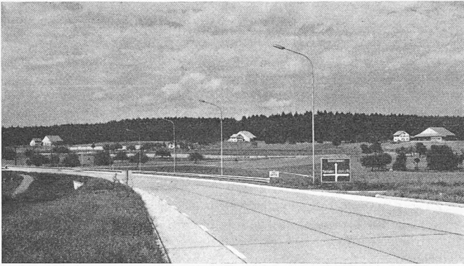
Bild 3. Parallel mit dem Bau der Nationalstrasse Winterthur—Schaffhausen ist die nördlich der Thur (Weinlandbrücke) gelegene Gemeinde Kleinandelfingen zusammengelegt worden. Vorsorglicher Landerwerb und enge Zusammenarbeit der zuständigen Organe ermöglichten es, den für die Strasse erforderlichen Boden bereitzustellen und 6 Landwirtschaftsbetriebe aus dem Dorfe in die vom Durchgangsverkehr abgeschnittenen Wirtschaftsgebiete zu verlegen. Das Bild zeigt einen Ausschnitt aus dem neu entstandenen Siedlungsgürtel an der nordöstlichen Peripherie der Gemeinde
