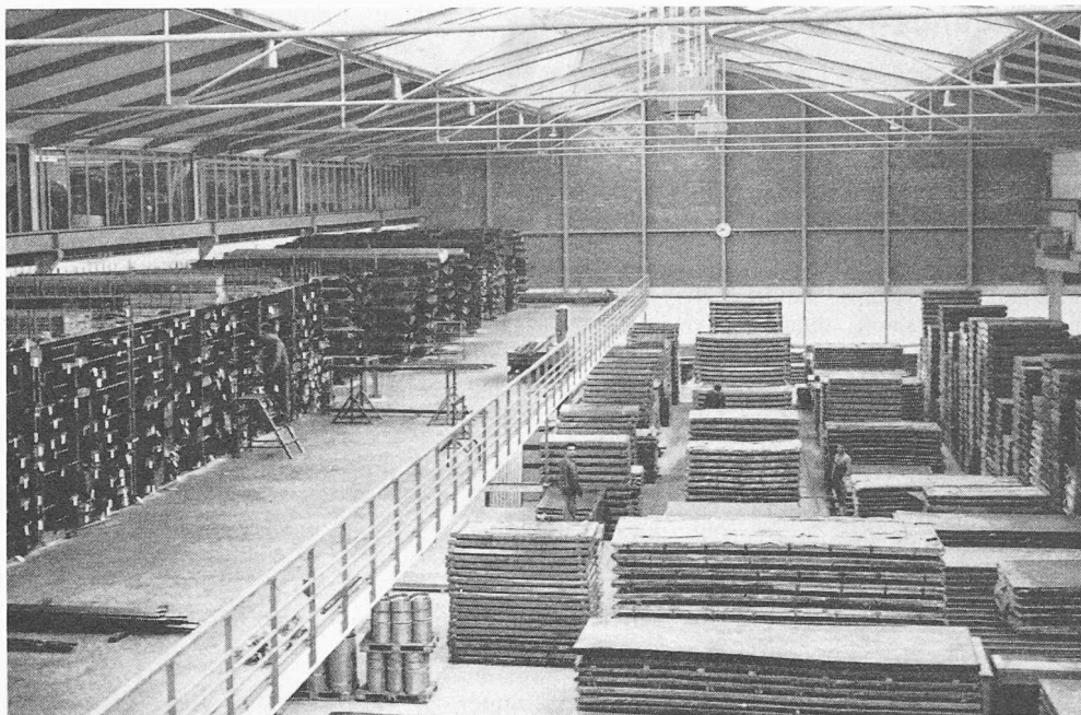
Blick in eine der sechs Lagerhallen mit Galeriegeschoss
