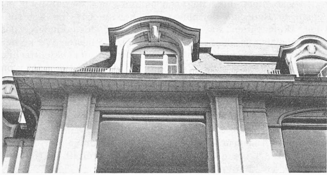
Bild 18. Dachpartie der Südfassade
