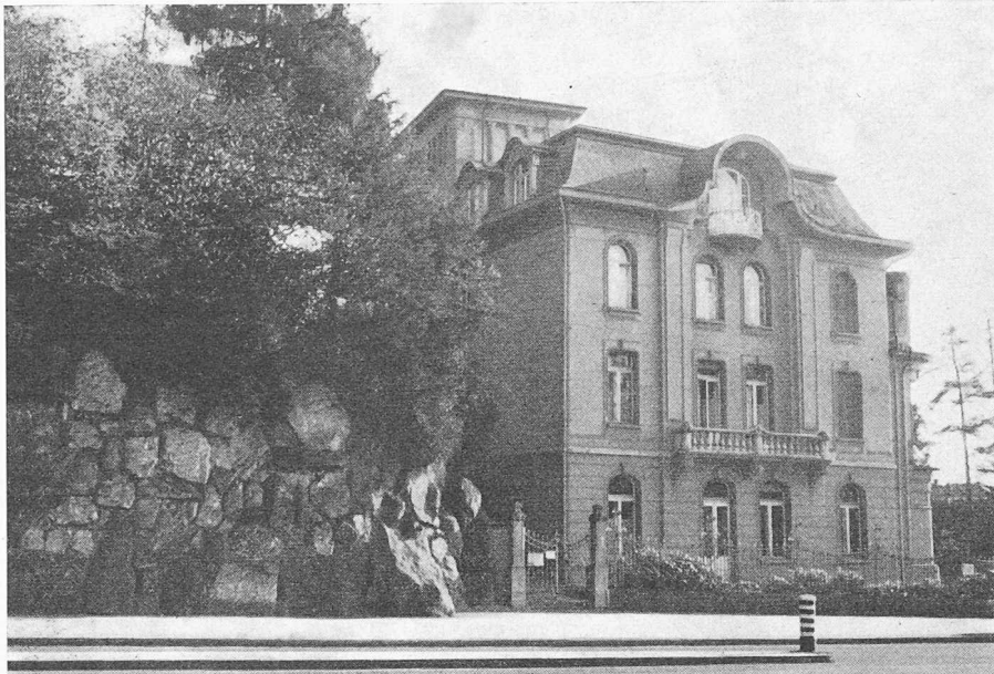
Bild 8. Westfassade (Kornhausstrasse) mit dem «Heilsarmeehut»
