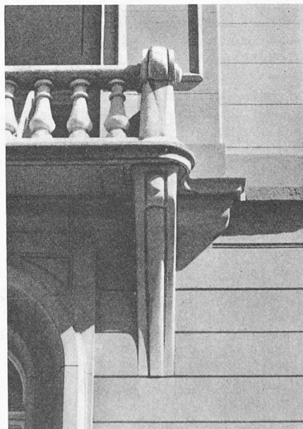
Bild 16. Balkonkonsole der Westfassade
