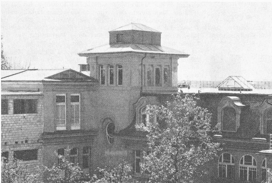
Bild 6. Nordfassade, östlicher Teil
