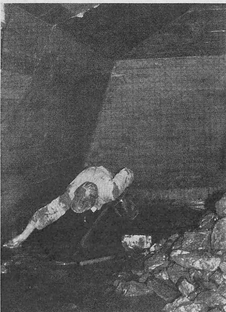
Bild 5. Achereggbrücke. Aushub unter der Schneide in der Arbeitskammer
