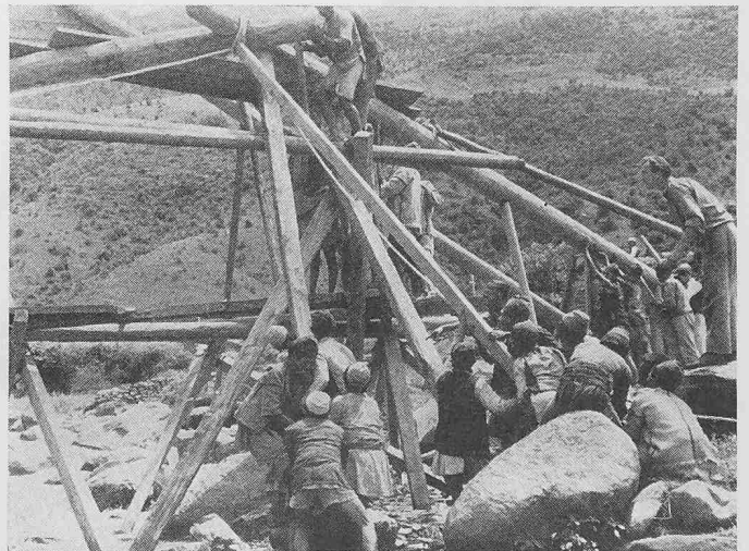
Bild 2. Brückenbau in Jiri
