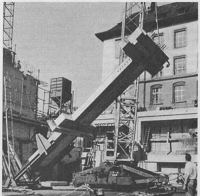
Bild 37. Aufrichten einer Kellerstütze durch den 60-t-Mobilkran
