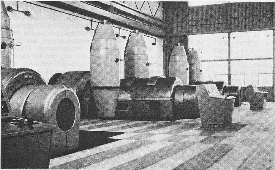
Bild 2. Gasturbinenhalle der Anlage A in Tivoli. Links die gasdichte Schottenwand zum Kompressorenraum, rechts die Kommando- und Steuerpulte für die einzelnen Maschinen- und Turbinengruppen
