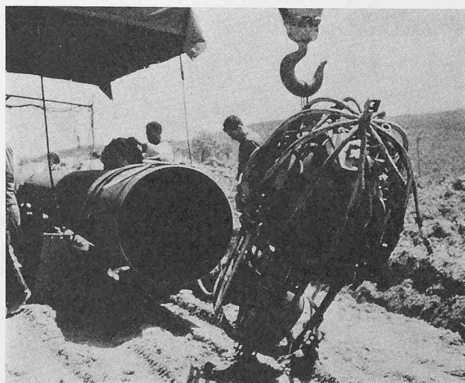
Spannvorrichtung zum Ausrichten zweier aneinanderzuschweisenden Röhre
