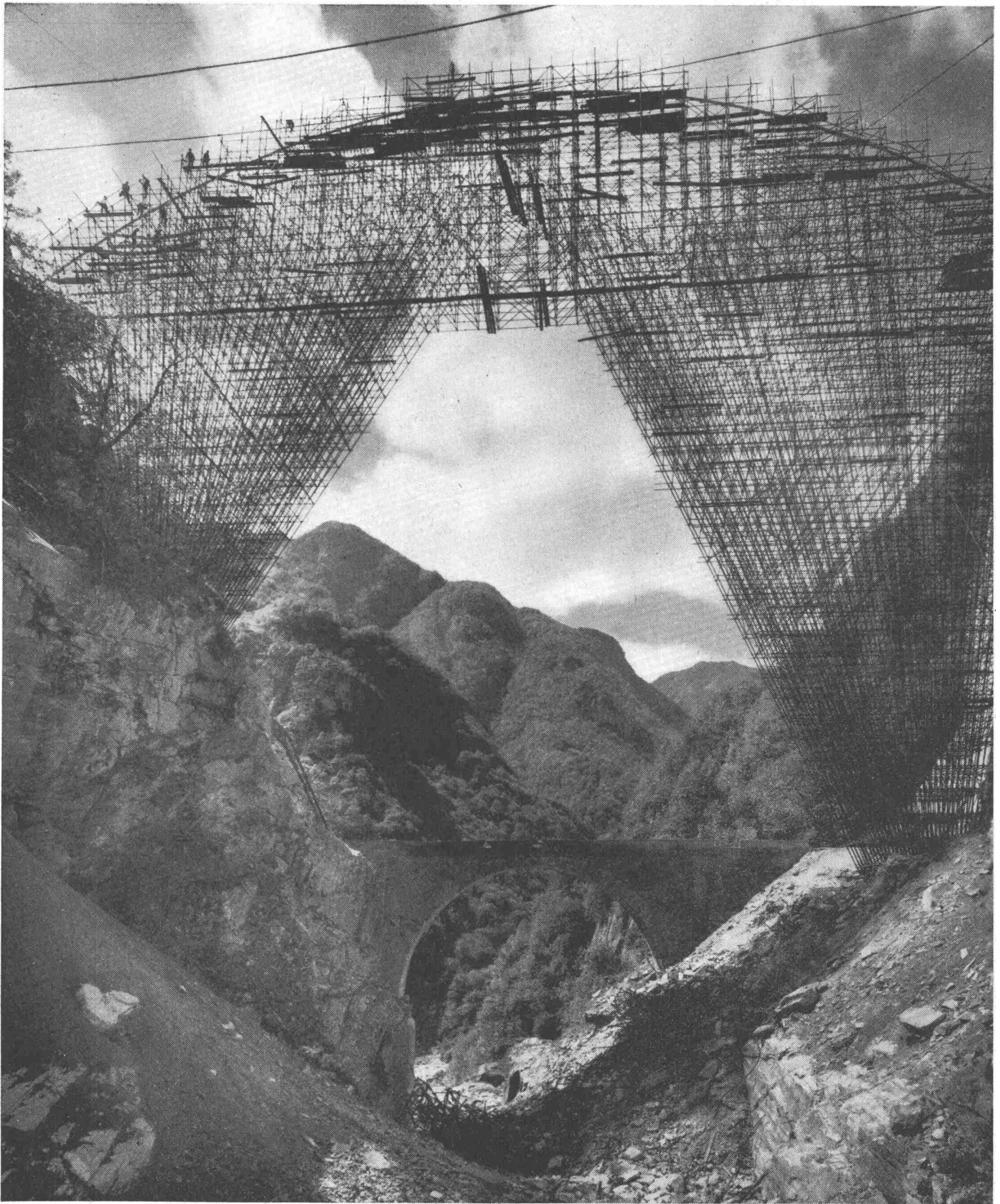
Lehrgerüst Val Porta, Verzasca-Tal TI
