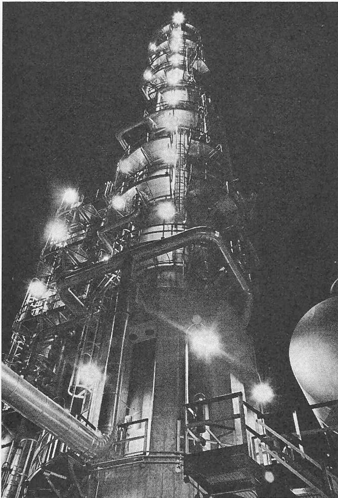
Bild 3. Fraktionierkolonne der Toppinganlage (Photo J. Rouiller, Lausanne)
