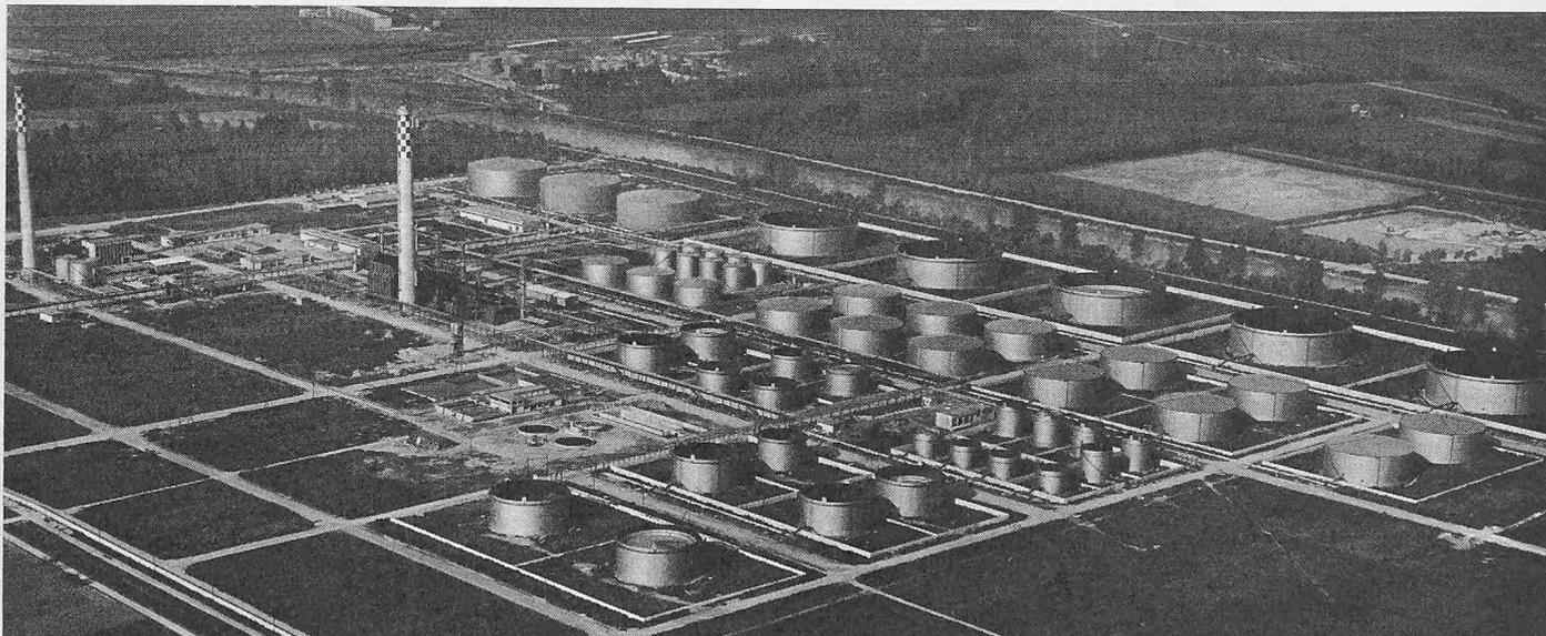
Wie dies in der Erdölindustrie, nicht zuletzt zur Brandbekämpfung, üblich ist, hat man die Verarbeitungseinheiten und Lagerbehälter locker auf schachbrettartig über das verfügbare Gelände verteilte Felder angeordnet, die durch breite Strassen getrennt sind. Aus Bild 1 ist sofort ersichtlich, dass heute erst ein Teil der vorhandenen Flächen überbaut ist und somit noch erhebliche Reserven zu späteren Ergänzungen verfügbar sind.
