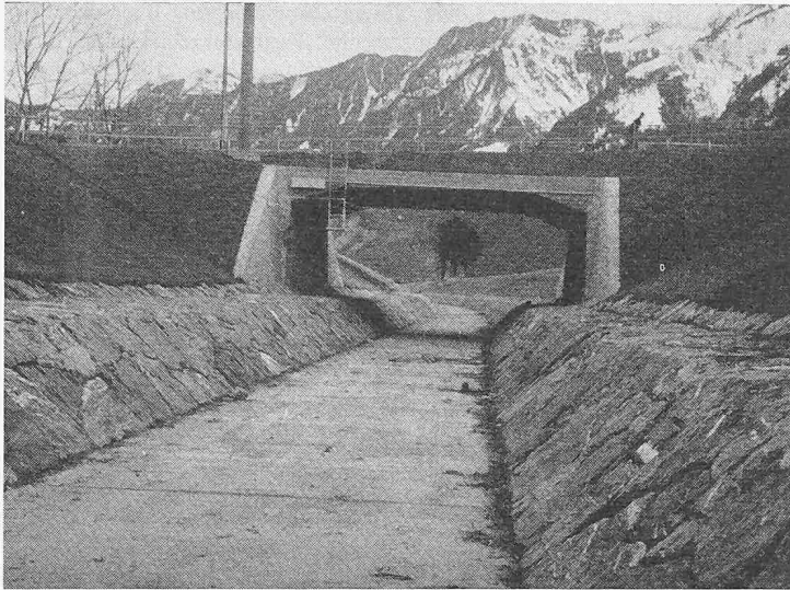
Bild 17. Detail des fertigen Kanales mit der seitlichen Pflasterung und der betonierten Sohle sowie der neuen Strassenbrücke Trübbach—Mäls FL.
