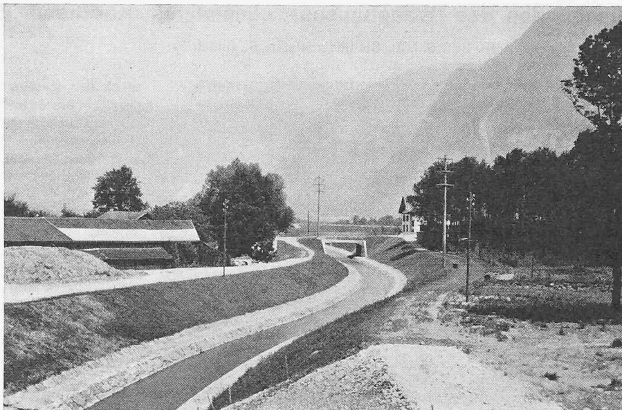
Bild 18. Der fertige Saarableitungskanal beim Dorf Trübbach.
