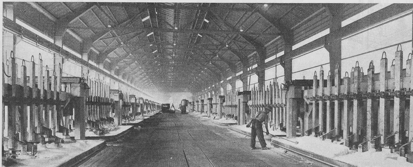
Bild 9. Die 513 m lange Ofenhalle mit 96 Elektrolyseöfen im Betrieb
