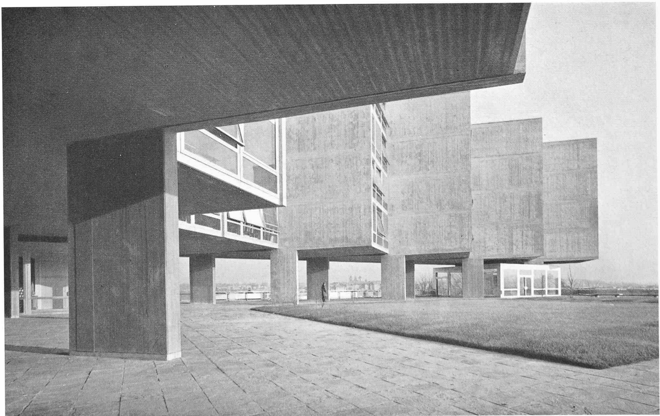
Ansicht aus Nordwesten mit der südöstlichen Treppenanlage
