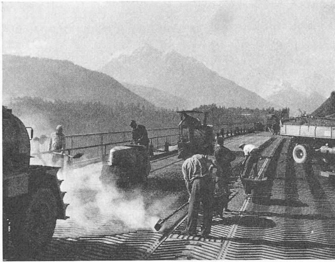
Bild 30. Fischgrätartig verlegte Stahlrippen auf ebenem Deckblech zur Sicherung des dünnen Schwarzbelages (Düsseldorfer Bauart)
