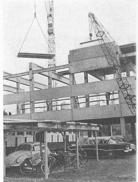
Bild 14. Verlegen einer vorfabrizierten Eisen- beton-Dachrippenplatte mit dem Turmdreh- kran (links). Montieren einer vorfabrizierten Leca-Fassadenplatte mit dem Autokran (rechts)
