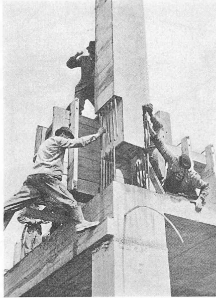
Bild 13. Die Stütze wird an ihren Standort versetzt
