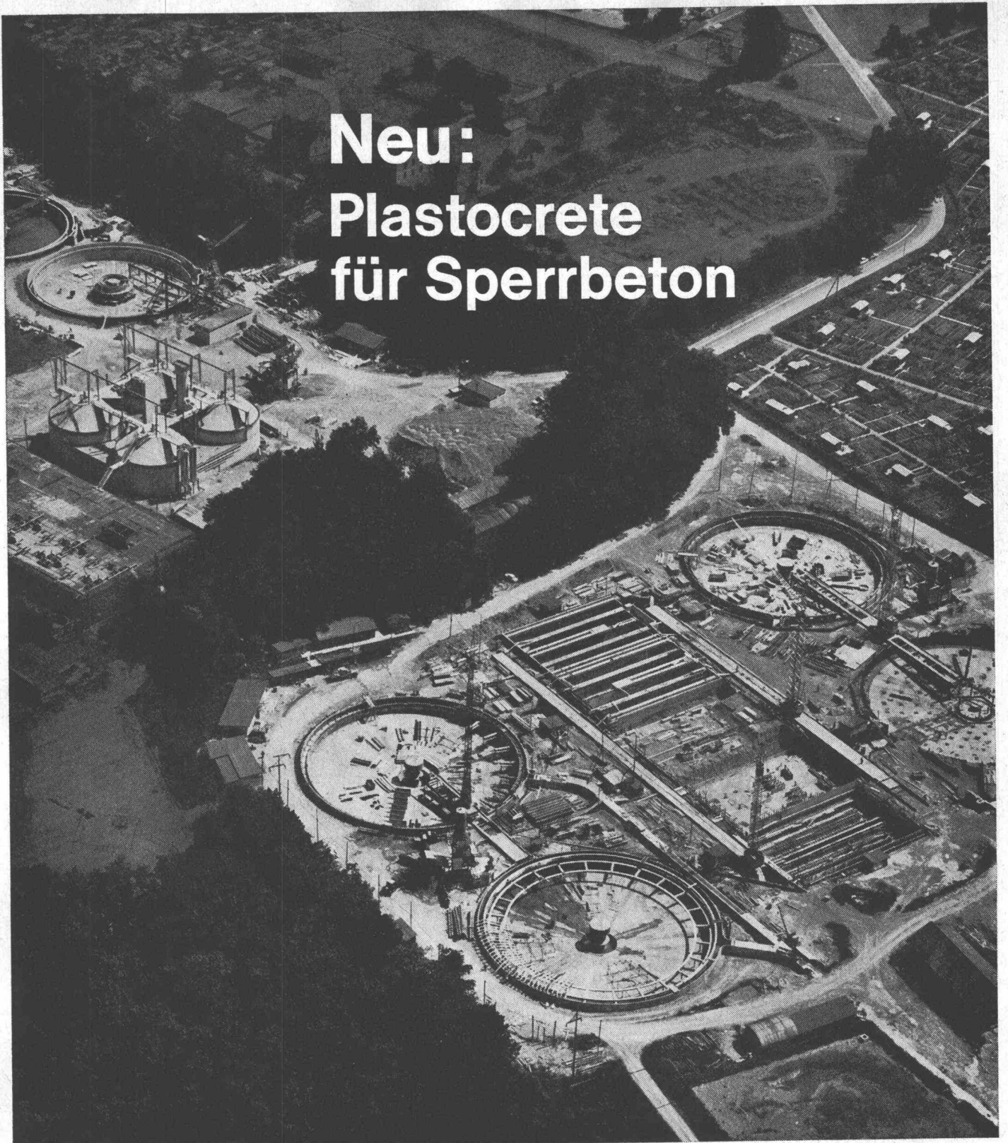
Kläranlage Werdhölzli Zürich
