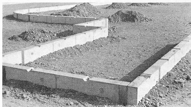
Bild 6. Betonfundament fur permanente Arova-Traglufthalle (Werk- und Lagerhalle)
