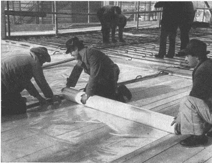
Polyäthylen «Howagaine» im Strassenbau
