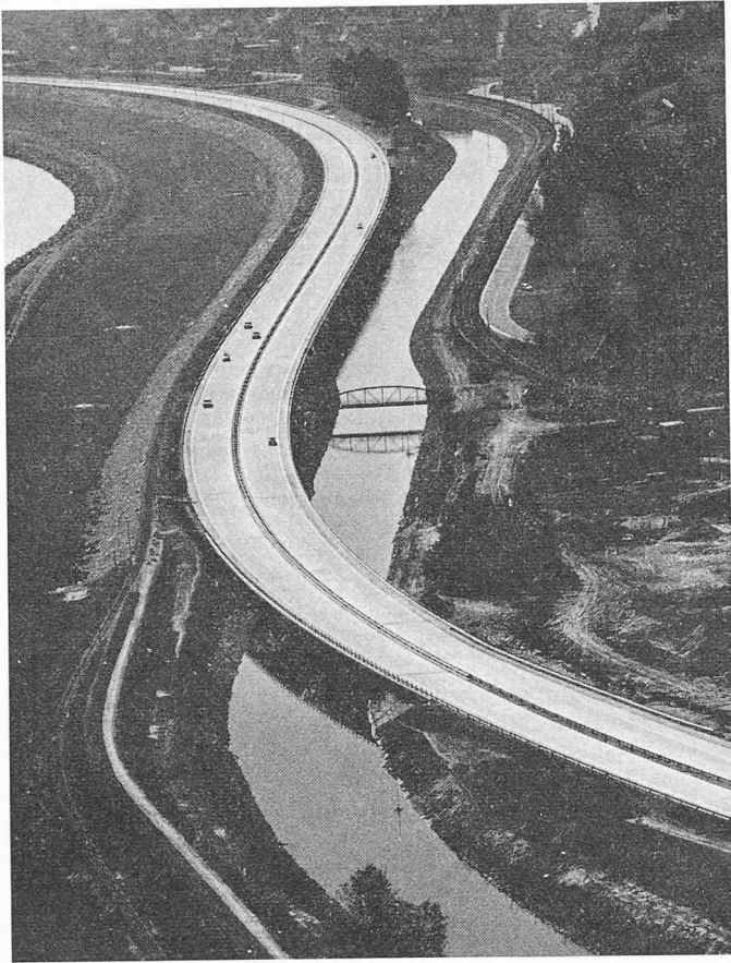
Bild 31. Zwillingenbrücke und Lehnviadukt St. Margrethen (Photo Comet)
