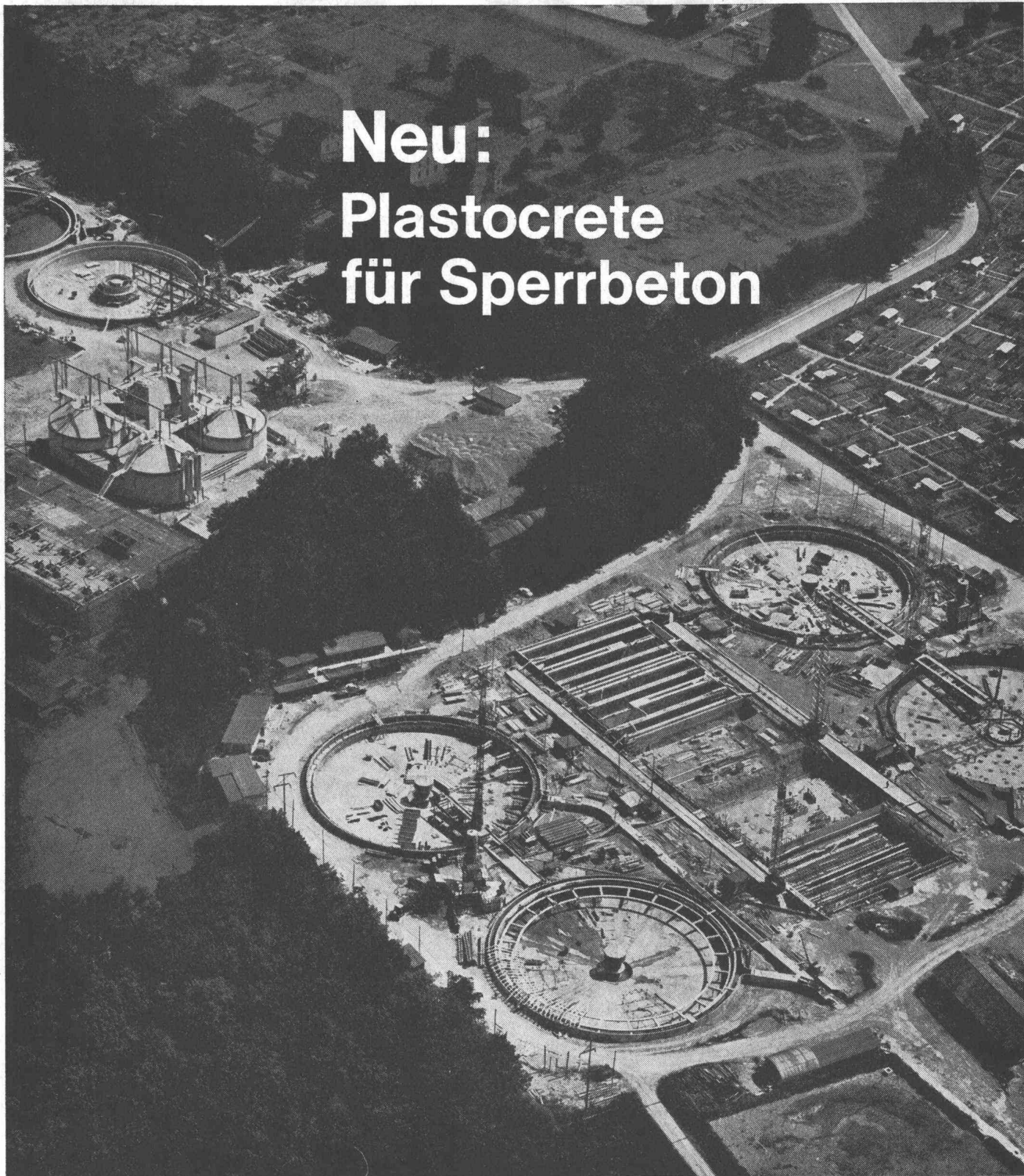
Kläranlage Werdhölzli Zürich
