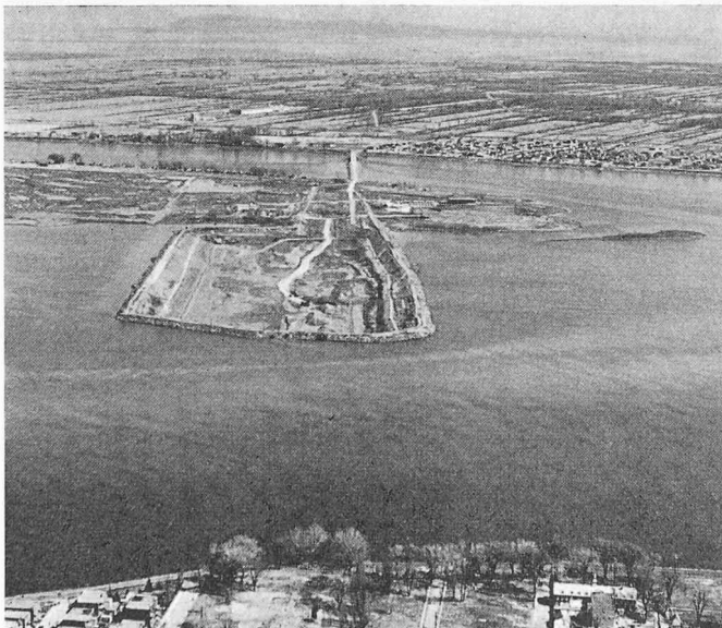
Bild 14. Ansicht der Baustelle. Im Vordergrund der Stadtrand von Montreal-Insel und der St. Lawrence-Strom mit einem 450 m breiten schiffbaren Kanal. In Bildmitte das fast fertig ausgehobene Trockendock (Bauzustand Frühjahr 1964) und die Insel Charron. Im Hintergrund Südkanal mit Brücke und Boucherville
