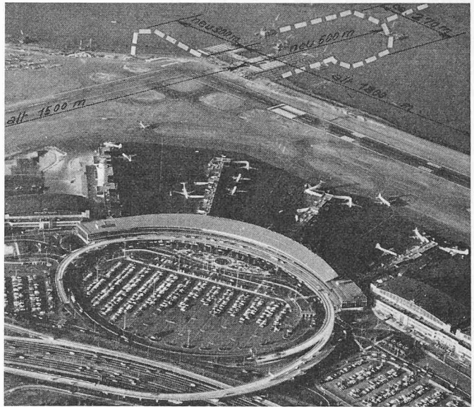
Bild 1. La Guardia Airfield, Verlängerung der Pisten in die Flushing Bay. Photo: The Port of New York Authority
